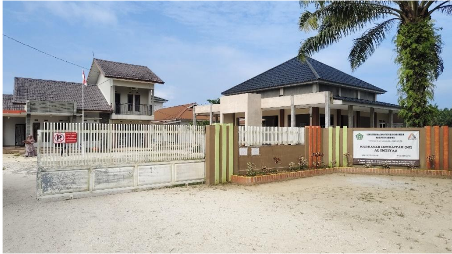
Tampak dari Luar Gedung kantor dan Masjid
