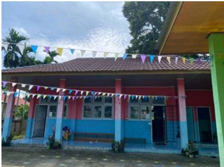
Gambar 4.2 Bangunan Kelas dan Toilet TK-At-Thoyyibah
